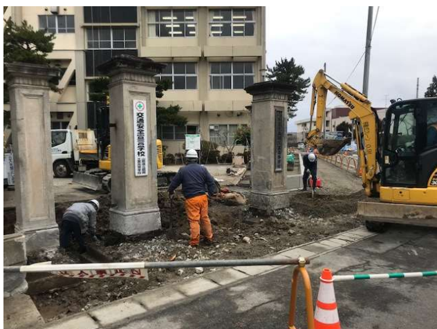
基礎まで掘り出し
