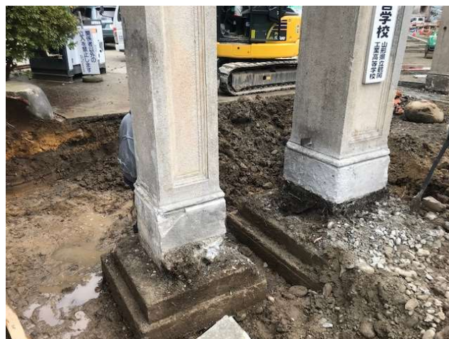
移転前はこの基礎上に設置された
